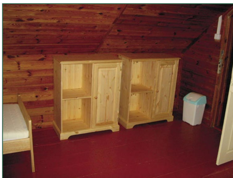
Vybavení novým nábytkem a rekonstrukce vnitřní části terénní stanice (Pavel Tater) New furniture and inside reconstruction of terrain station (Pavel Tater)
