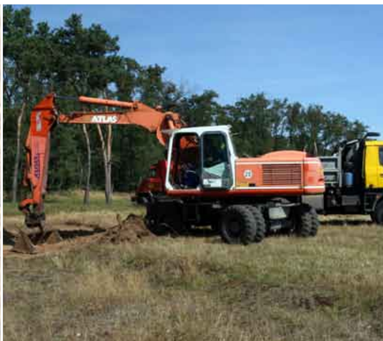
Strhávání drnu těžkou technikou / Mechanized removing of humus layer
