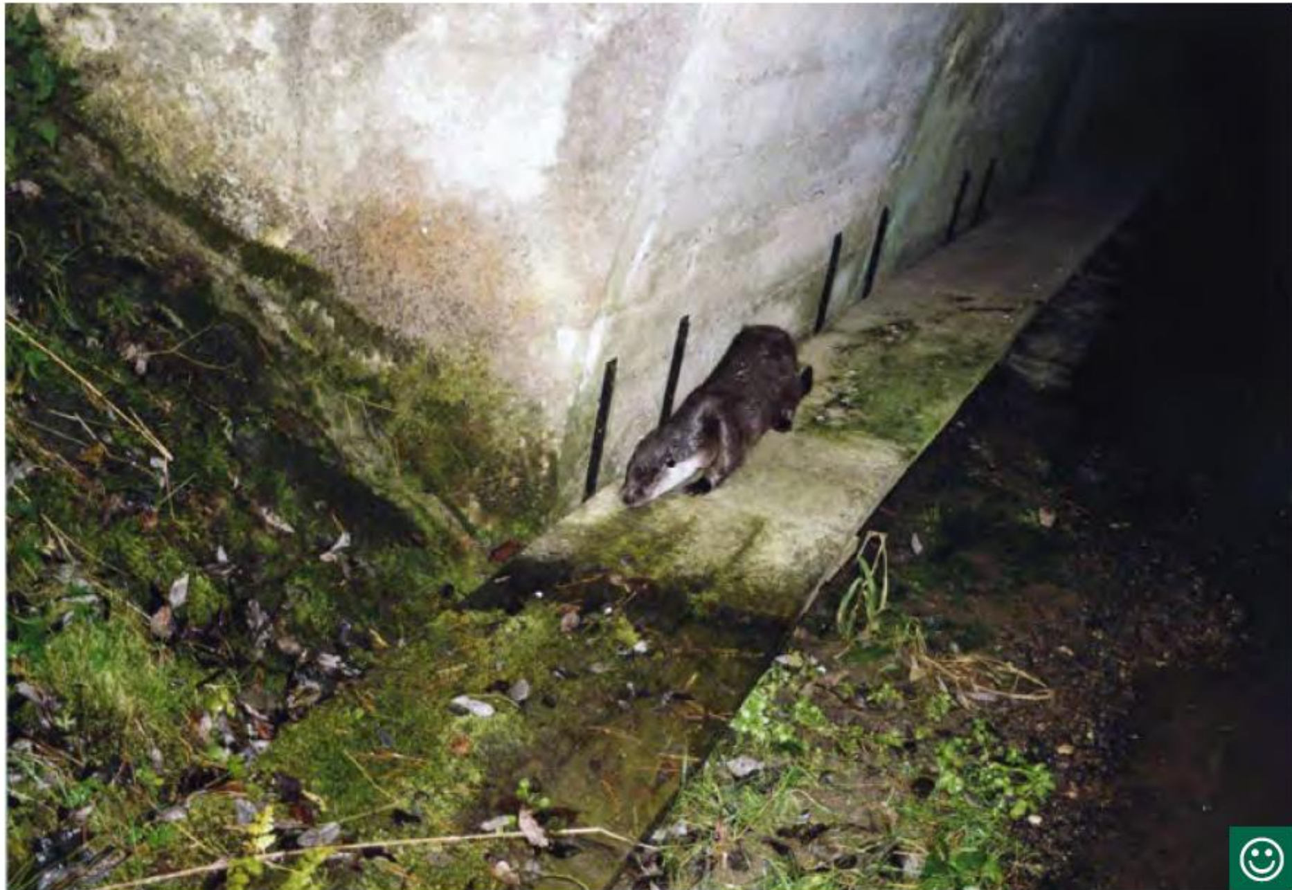
Obr. 10.36 Průchodnost mostů, u kterých voda sahá od opěry k opěře, lze zlepšit instalací 40 cm široké dřevěné lávky, umístěné cca 30 cm nad běžnou hladinou vody. Lávky využívá liška, vydra i všechny menší lasicovité šelmy. Zásadním požadavkem je plynulé napojení lávky na okolní terén. (© Václav Hlaváč)
