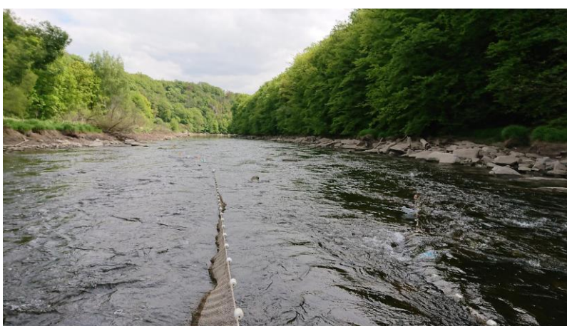
Obr. 16. Detail naváděcích ramen vězence (foto: Miroslav Barankiewicz)
