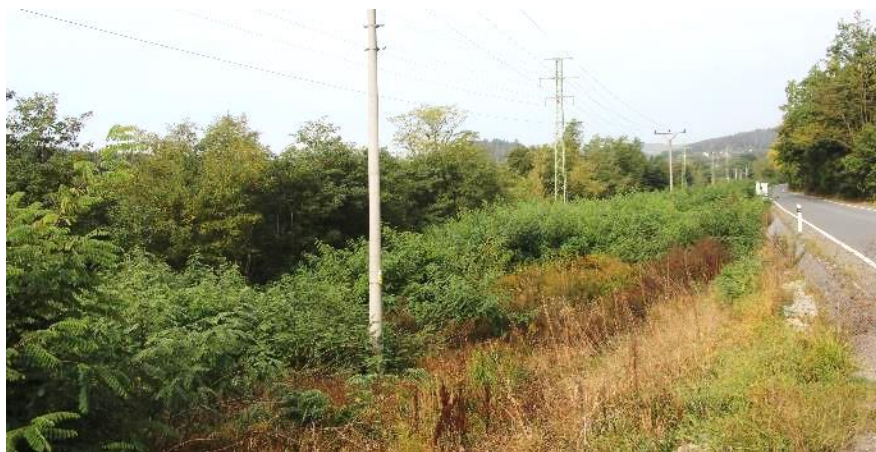
Obr. 70: Příklad nevhodného managementu, kdy pod sloupy s elektrickým vedením vyfrézovaný trnovník akát po půl roce vytvořil četné výmladky. [JPe]
